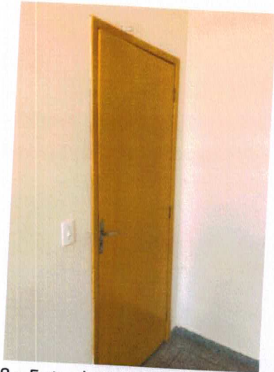
Figura 38 – Foto da Parede: Porta empenada - SAÍDA PARA CONSULTÓRIO
