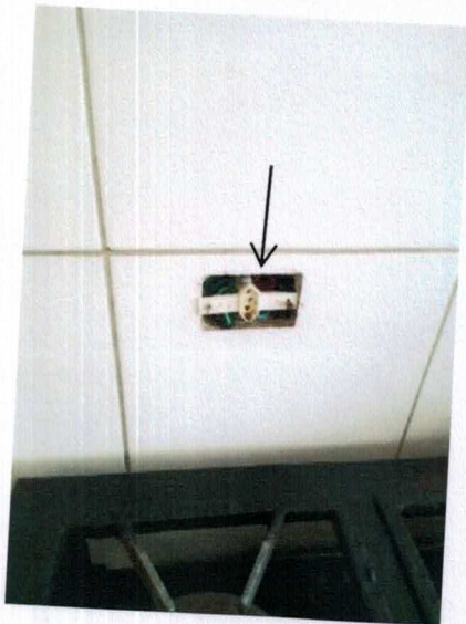
Figura 48 – Foto Da Parede : Tomada sem espelho - PÁTIO
