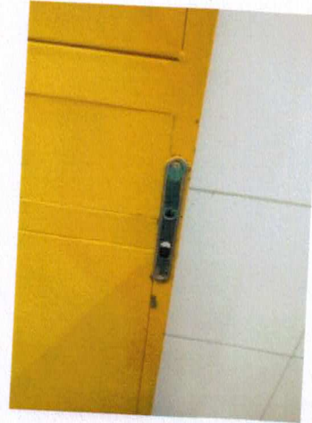
Figura 39 – Foto da Porta: Porta sem fechadura - CONTROLE
